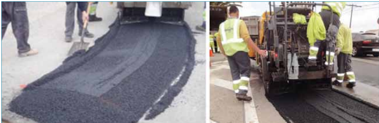
Figura 8. Extensión de la mezcla bituminosa en caliente.
