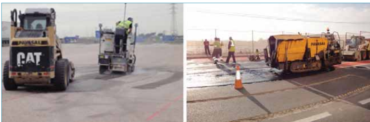
Figura 7. Proceso de integración en el firme existente.
