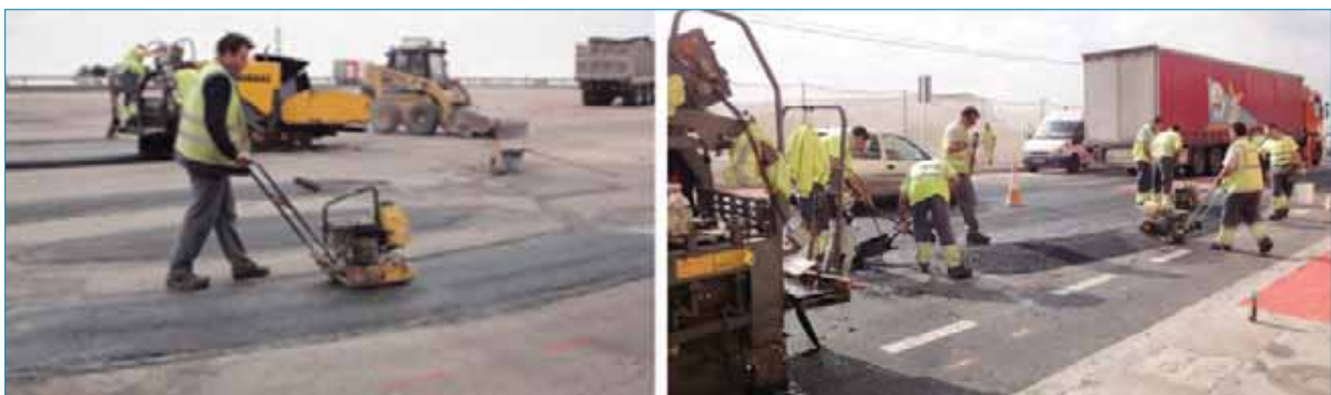
Figura 9. Compactación de la mezcla bituminosa.
