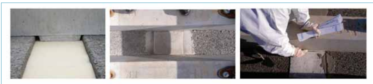
Figura 15. Fotografías del relleno intertraviesa.
