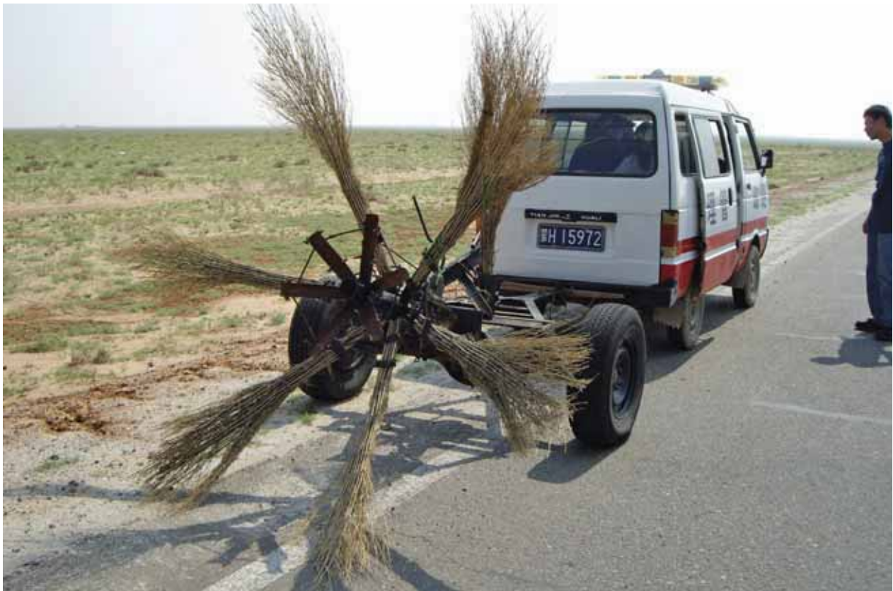
Obra de pavimentación en China (2006).
