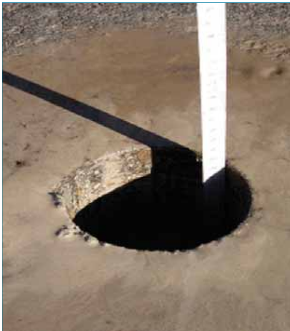
Figura 1: Detalle de la extracción de un testigo.
