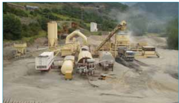
Foto 1. Vista de la planta.
