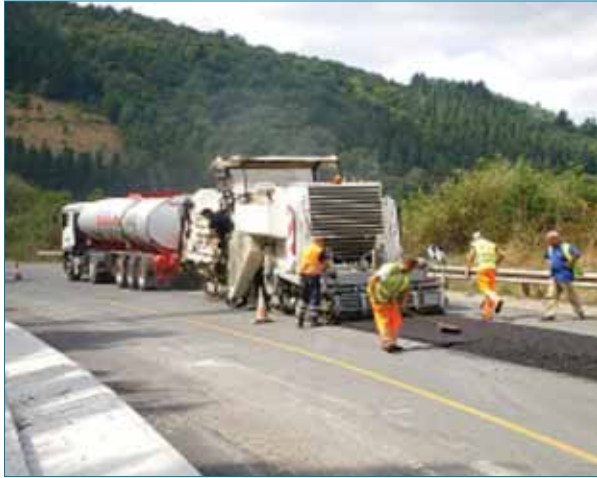
Figura 4: Recicladora mezcladora con regla de extensión y precompactación.
