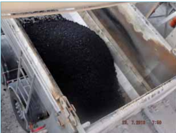
Figura 9. Control de temperaturas de mezcla y ausencia de emisiones de humos.
