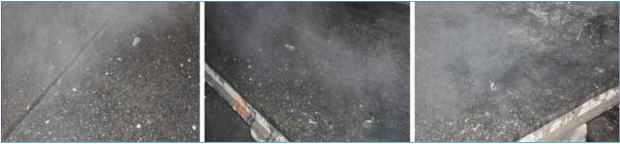
Figura 25:- Estado del firme superficial de la mezcla bituminosa AC16S aditivada con el 1,4% después del ensayo con incendio de un coche.
