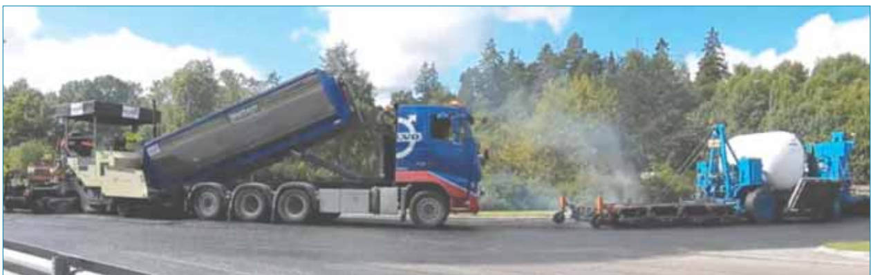
Figura 7- Precalentamiento de superficie, delante del extendido, con equipos con calentadores de gas.
