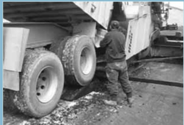
algún tipo de calzos para evitar que se dañe la extendedora o que se modifique el espesor de mezcla extendida al elevar la regla de extendido.
