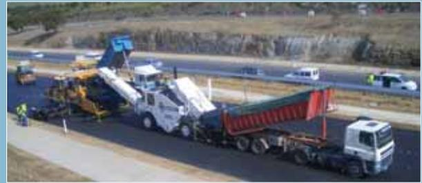
cho tiempo la mezcla a alta temperatura, pues esta situación favorece el envejecimiento prematuro del ligante, afectando a la calidad final de la capa de mezcla bituminosa construida. Si esta situación se produce con frecuencia, es preferible disponer de vehículos con aislamiento térmico de la carga, antes que elevar sistemáticamente la temperatura de fabricación de la mezcla.
