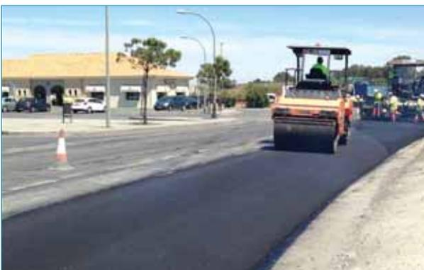
Figura 10. Compactación de la mezcla en la reposición de la capa fresada previamente.
