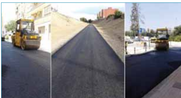
Figura 3: Obras en Benimamet ejecutadas con mezclas fabricadas con betunes espumados.
