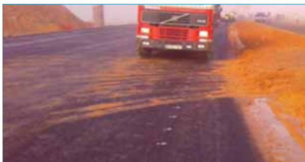
Fig. 4 Situación indeseable e inadmisible a evitar.
