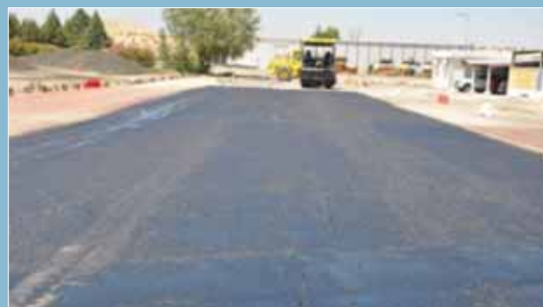
Preparación de la superficie para realizar un tramo de prueba.
