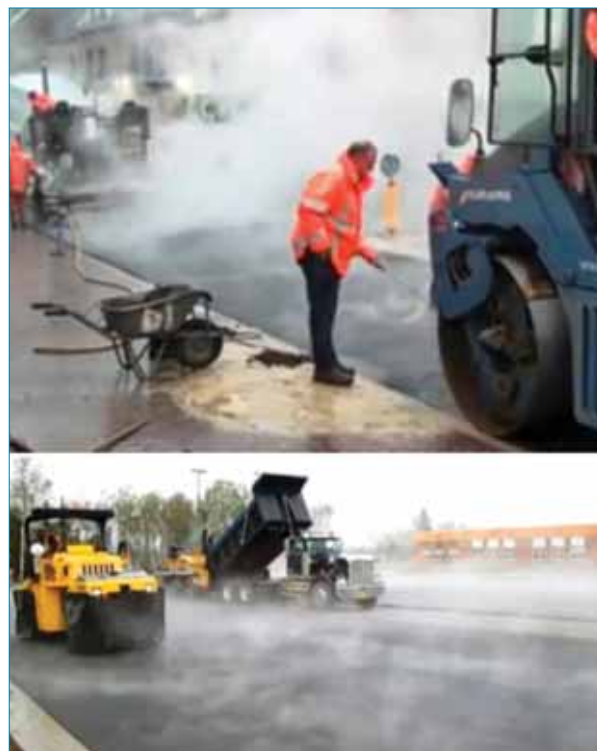
Fig. 1. Lluvia sobre la capa en ejecución de mezclas en caliente y su evaporación
