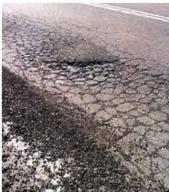
Zona de deterioro estructural (capas subyacentes) y reparación inadecuada de baches.
