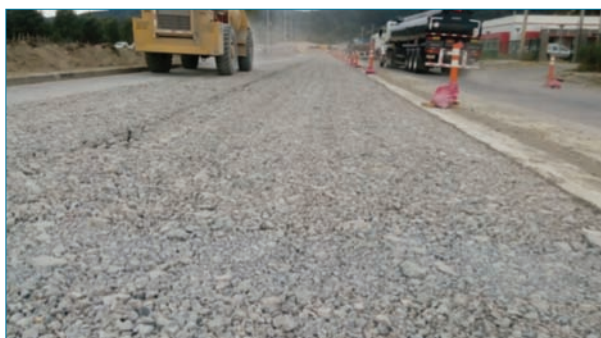
Foto 1. Pavimento de hormigón fracturado (Fuente: Antigo).
