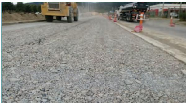
Foto 1. Pavimento de hormigón fracturado (Fuente: Antigo).
