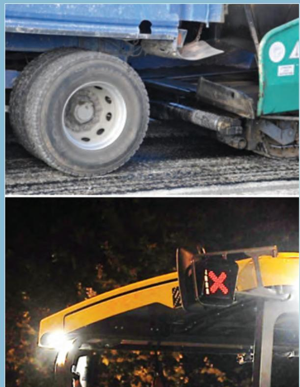
Aproximación del camión a la extendidora. Abajo, dispositivo en la extendidora que avisa al conductor del camión en la aproximación
