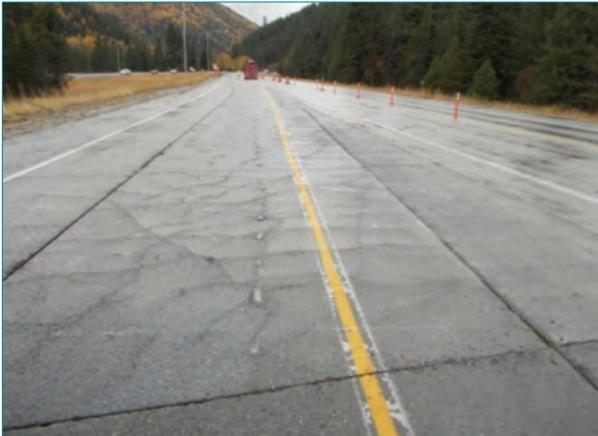
Foto 1. Pavimento de hormigón fracturado (Fuente: Antigo).
