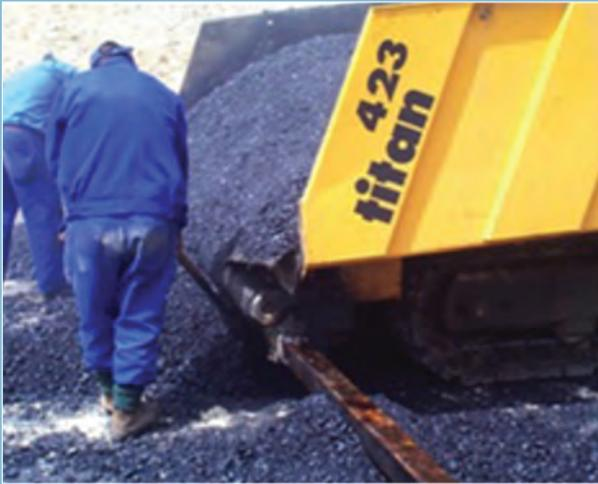
Vertido incontrolado de mezcla bituminosa delante de la extendidora.
