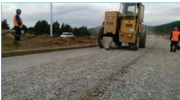
Foto 5. Equipo de desintegración por resonancia. (Fuente: Sacyr).
