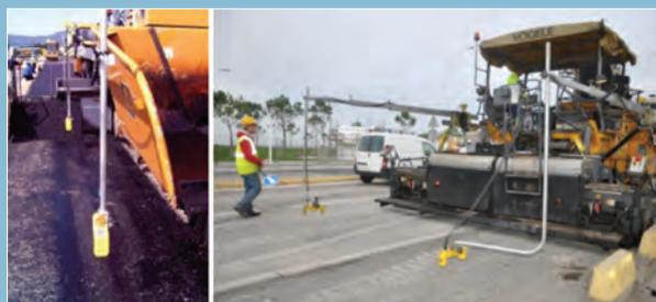
Sistemas de nivelación por láser o por ultrasonido.
