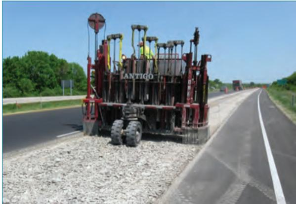
Foto 6. Equipo de desintegración por impacto. (Fuente: Antigo).
