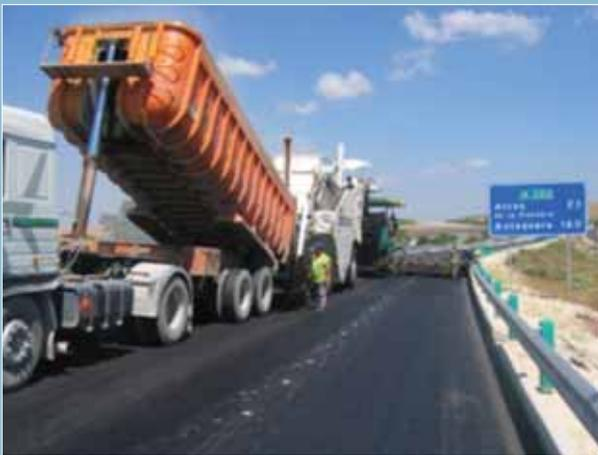
máquinas especiales que se deben utilizar en obras muy grandes pues la preparación de la regla de extendido es muy complicada. Se debe prestar especial atención a la nivelación a todo el ancho de extendido y cuidar que no se produzca una pérdida de la alineación de la regla de extendido.
