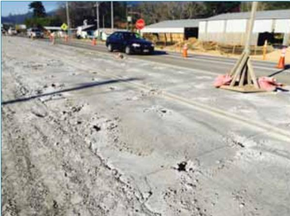
Foto 9. Desintegración de doble losa de hormigón. Detalle de los taladros en el pavimento.
