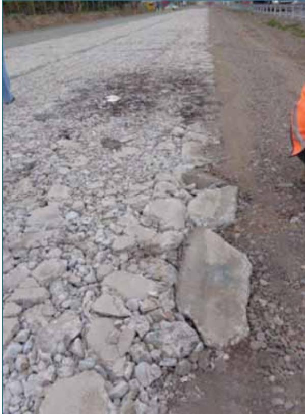
Foto 6. Zona deformada por problemas de base. Detalle de una zona puntual con desintegración incorrecta.
