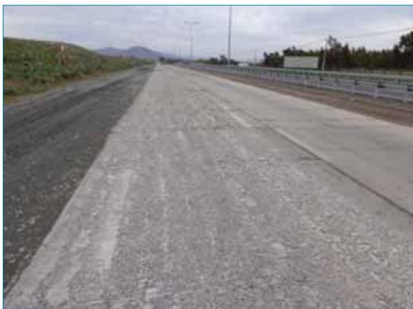
Foto 12. Tramo después de la desintegración de un carril.
