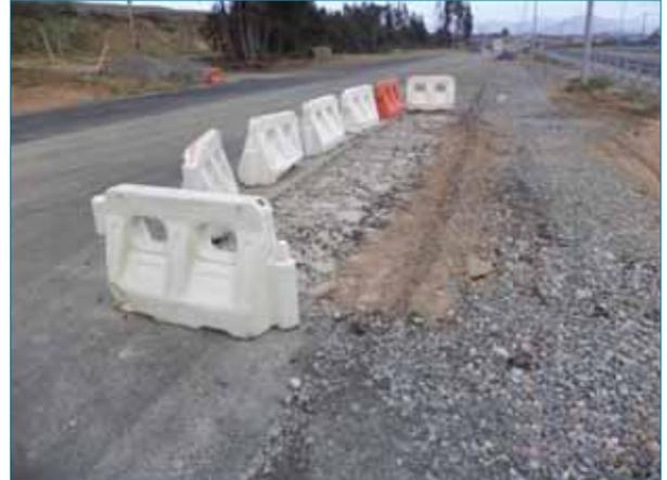
Foto 7. Zona deformada por problemas de base. Detalle de la retirada de la capa de mezcla bituminosa antes de la sustitución del material.
