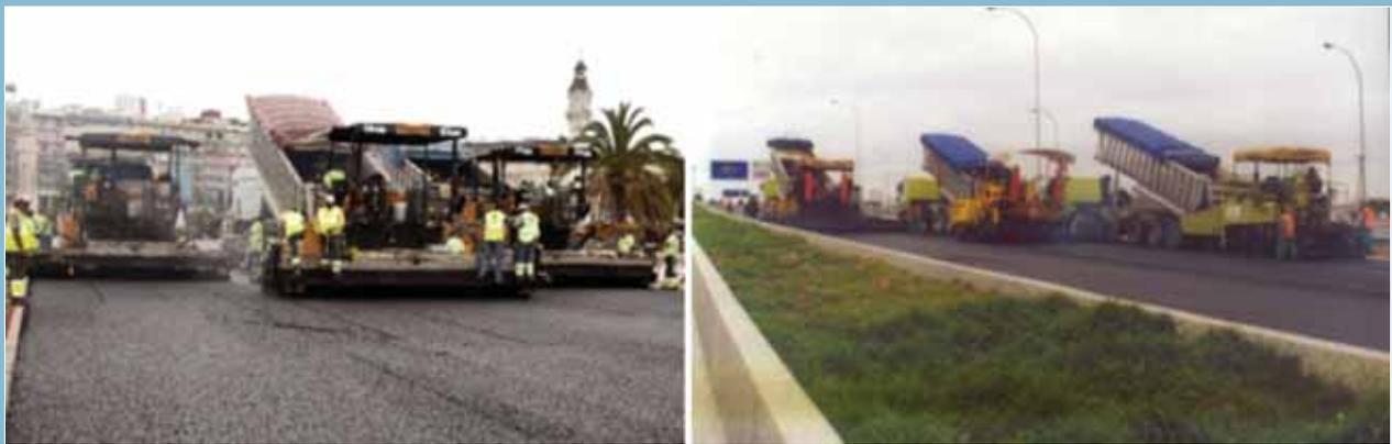
Construcción de junta longitudinal en caliente.
