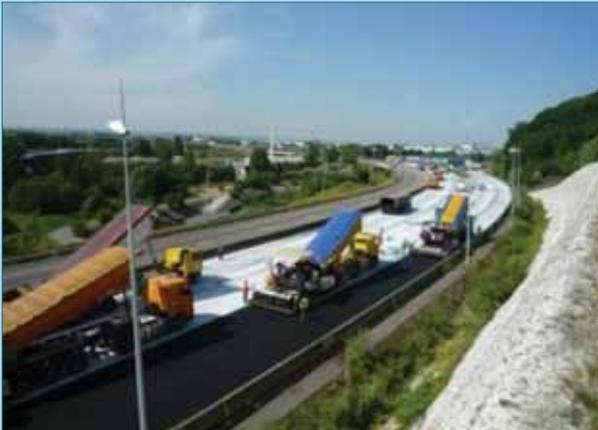
Foto 3. Puesta en obra de mezclas bituminosas con riego de adherencia tratado con leche de cal en la autopista A-29 en Francia (foto cedida por Lhoist).
