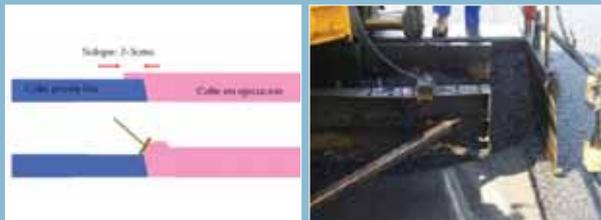
Correcta ejecución del solape en las juntas longitudinales frías.
