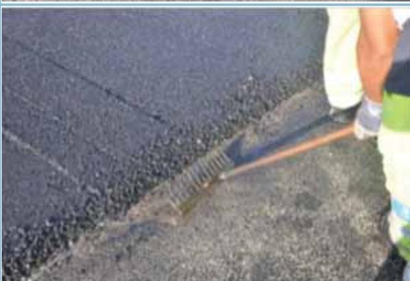
Correcta ejecución de una junta transversal.
