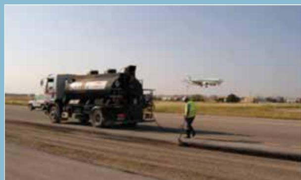
Riego de una junta longitudinal en frío.
