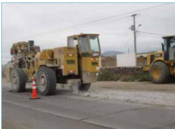
Foto 1. Desintegración de pavimento de hormigón en Ruta 43. Tramo urbano Pan de Azúcar (Chile)
