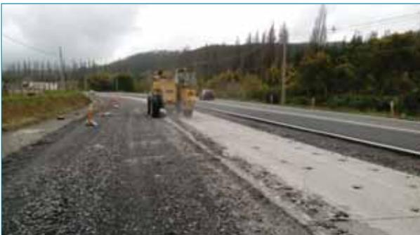
Foto 10. Desintegración de doble losa de hormigón. Paso 2: Desintegración del pavimento.
