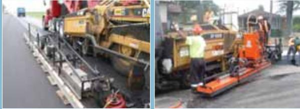
Dispositivos para calentar el borde de la capa existente en las juntas longitudinales frías.
