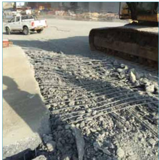
Foto 17. Detalle de la armadura del pavimento despegada del material desintegrado.
