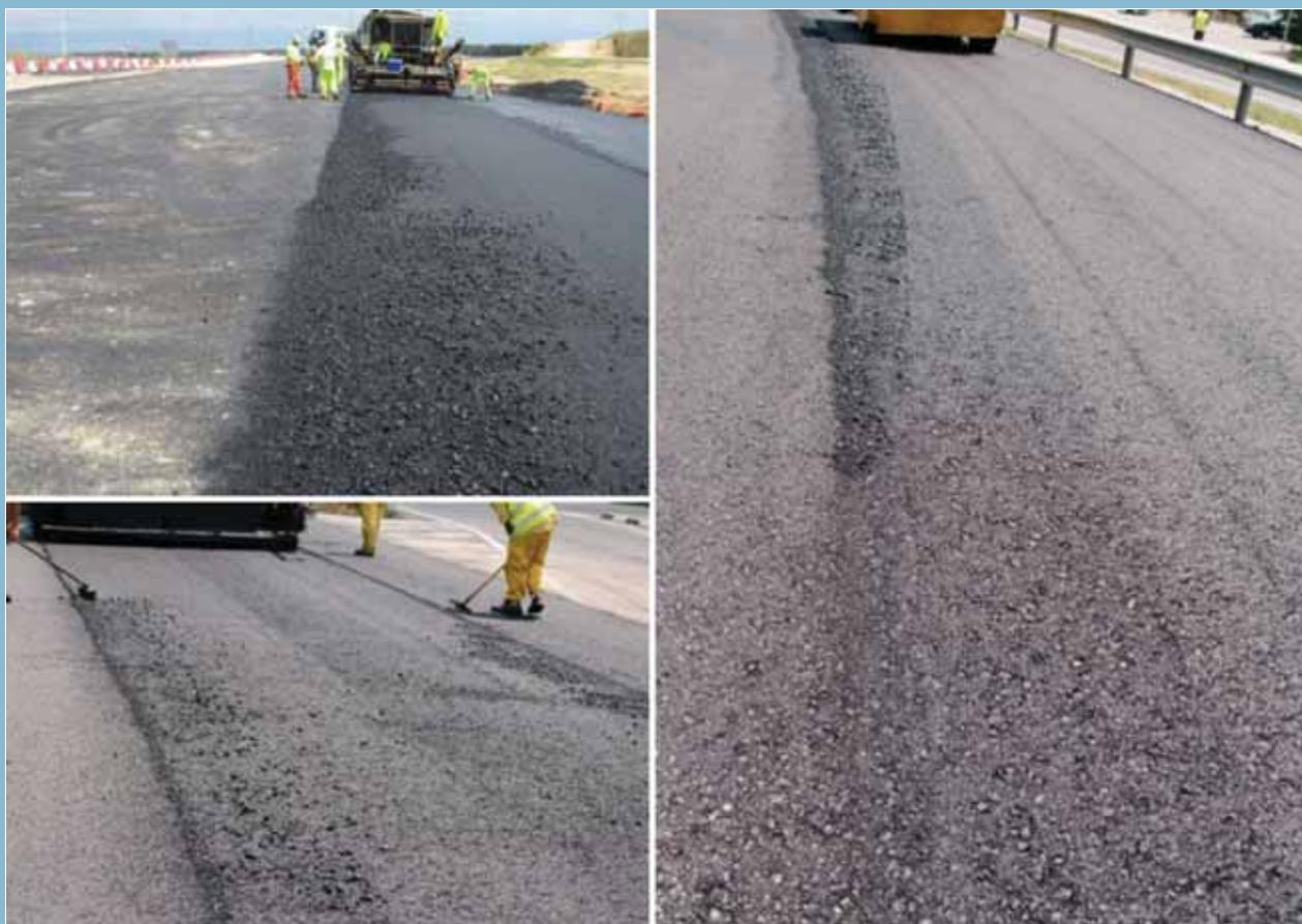
Junta longitudinal mal ejecutada por no retirada del árido grueso del borde.
