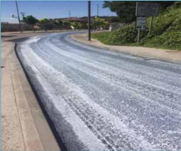
Foto 5. Detalle de la leche de cal encima del riego de adherencia en la carretera N-230. Tramo: Travesía de Almenar.
