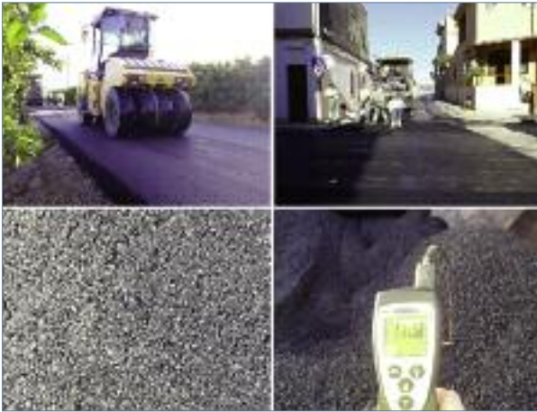
Figura 7: Imágenes de obra en Pedralba ejecutadas con mezclas recicladas semicalientes con espuma de betún.
