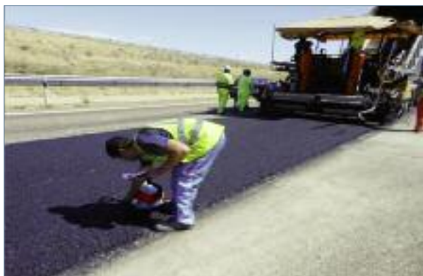
Figura 14. Extendido de la capa de base MBT AC22 con 50% RAP.
