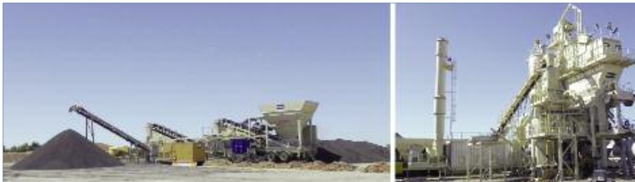
Figura 13. Instalaciones utilizadas en la A231. Fraccionamiento de RAP y fabricación de mezcla.
