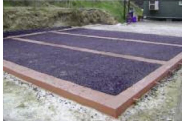
Figura 10. Detalle de las cuatro secciones del tramo de prueba.
