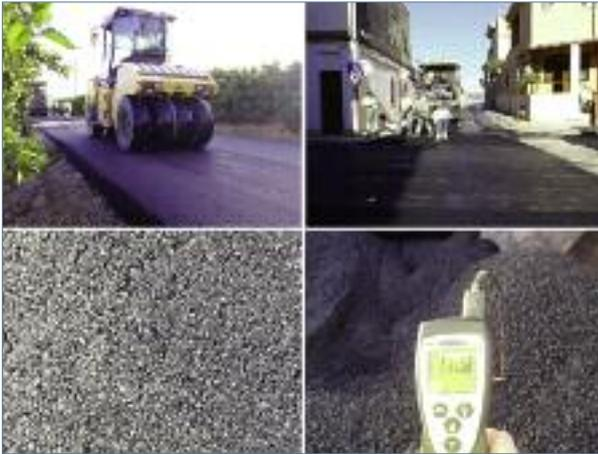
Figura 7: Imágenes de obra en Pedralba ejecutadas con mezclas recicladas semicalientes con espuma de betún.
