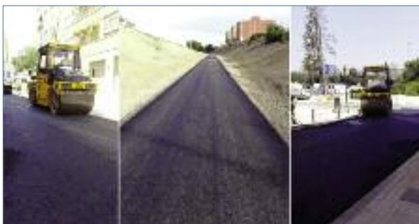
Figura 3: Obras en Benimamet ejecutadas con mezclas fabricadas con betunes espumados.
