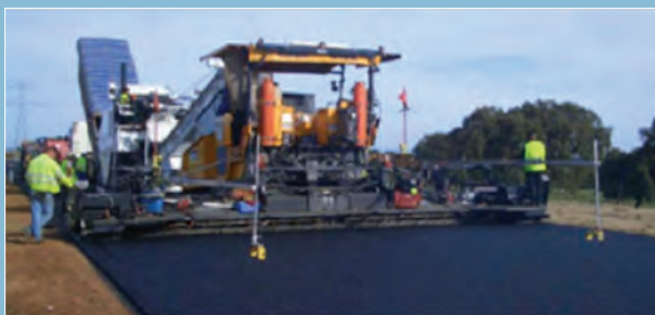
Vigas de nivelación
