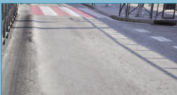
Figura 14. Evolución de una zona de rodera con el paso del tiempo y del tráfico.
