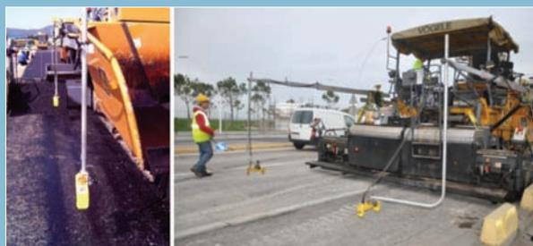
Sistemas de nivelación por láser o por ultrasonido.
