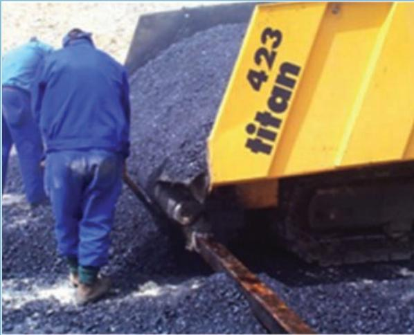
Vertido incontrolado de mezcla bituminosa delante de la extendedora.
