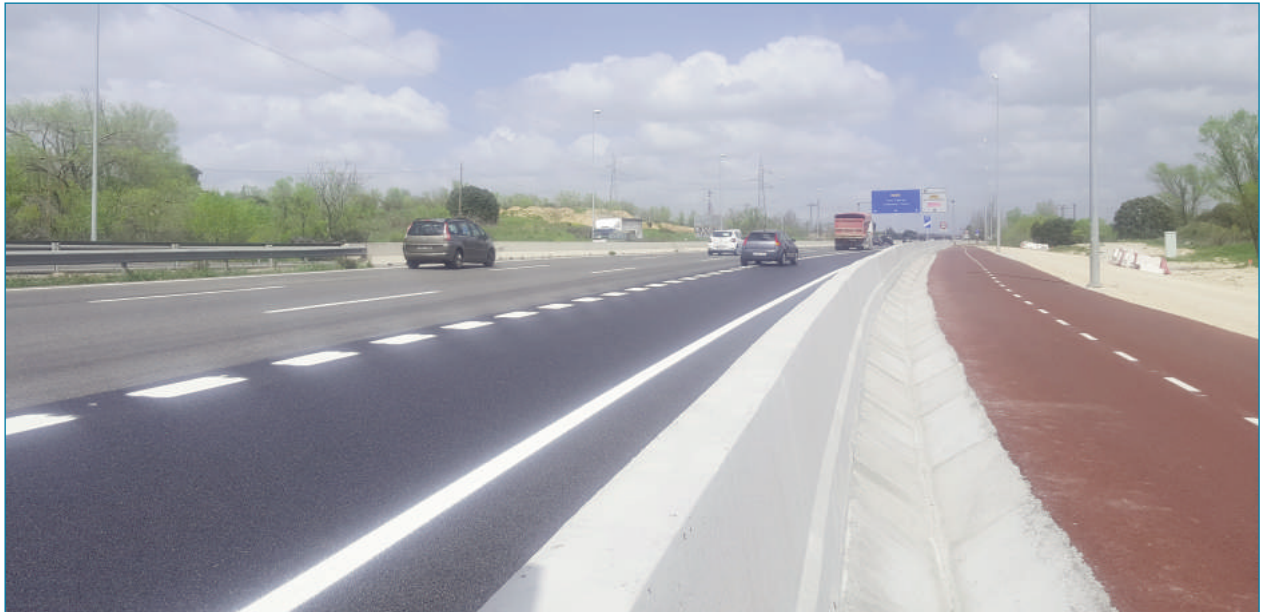
Figura 7. Tramo finalizado y puesto en servicio
