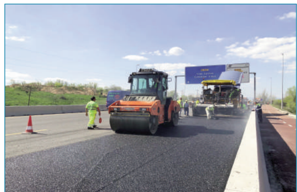
Figura 6. Ejecución de la capa intermedia (izquierda) y de rodadura (derecha)
