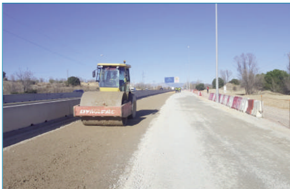
Figura 5. Ejecución de la capa de subbase (izquierda) y de base (derecha)
