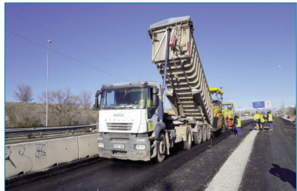
Figura 5. Ejecución de la capa de subbase (izquierda) y de base (derecha)
