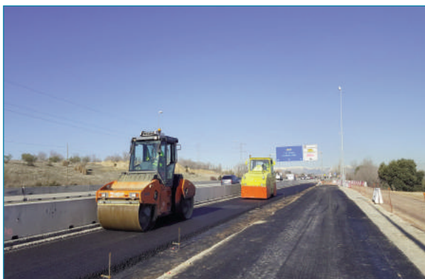
Figura 6. Ejecución de la capa intermedia (izquierda) y de rodadura (derecha)
