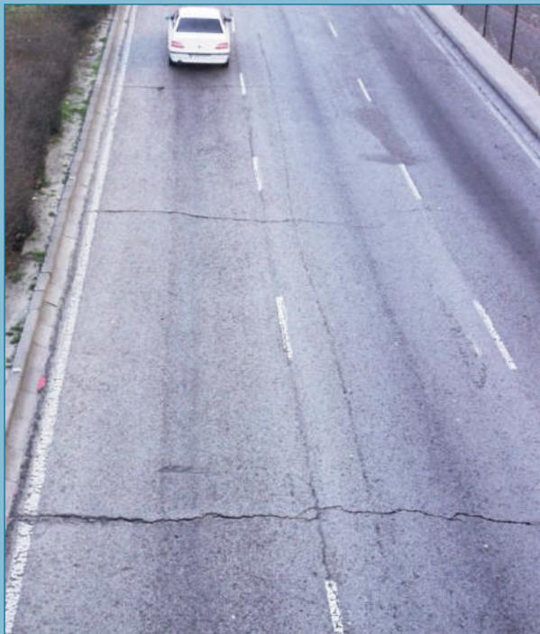
Figura 49. Superficie de rodadura con grietas reflejadas.
