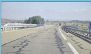
Figura 47 . Sellado de las grietas existentes.
