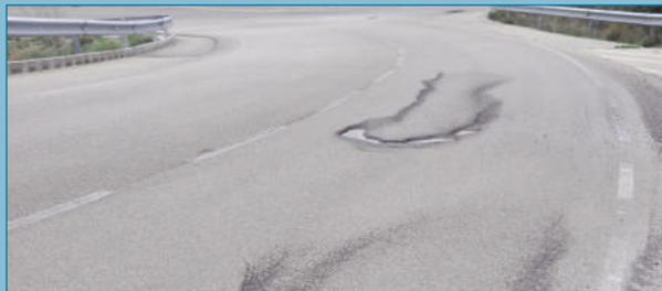
Figura 38. Fisura parabólica.
