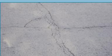
Figura 50. Deterioro de los bordes en las grietas reflejadas.
