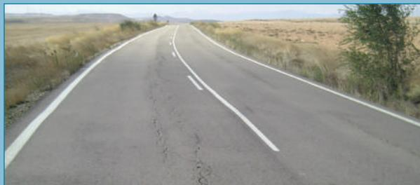
Figura 37. Fisura errática.
