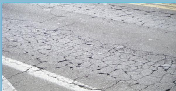
Figura 40. Fisuración estructural en zona de rodadas.
