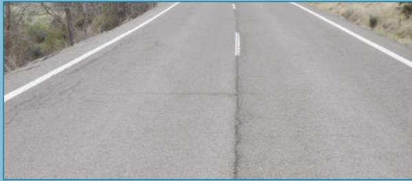
Figura 35. Fisura longitudinal.
