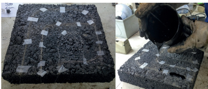
Figura 4. Prueba con ranura y producto para sellado de grietas. Fibra colocada en la ranura (izda.) y colocación del producto bituminoso (dcha.).
