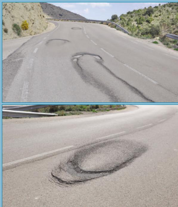
Figura 69. Grietas parabólicas con desprendimiento de material suelto de la mezcla bituminosa.
