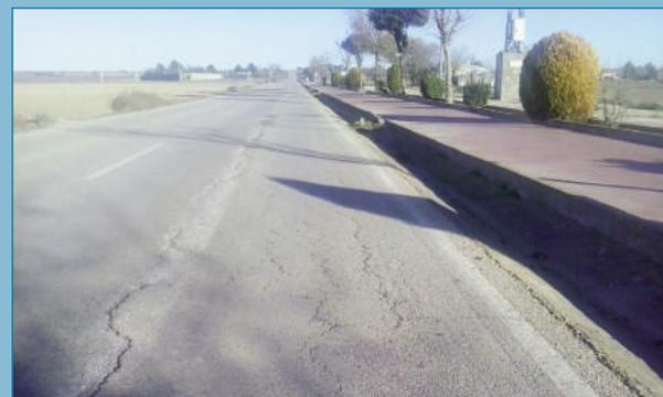
Figura 62. Grieta constructiva por asentamiento de zonas de ensanche realizadas en una antigua carretera.
