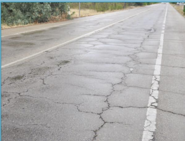
Figura 52. Fisuración descendente longitudinal y posteriormente con fisuras transversales en todo el pavimento.
