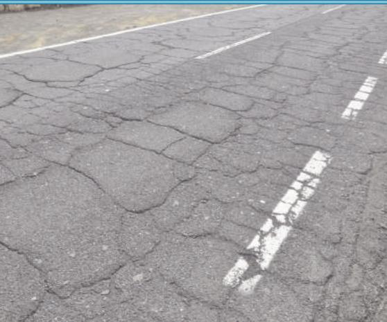
Figura 55. Pavimentos muy envejecidos y con abundante fisuración descendente.
