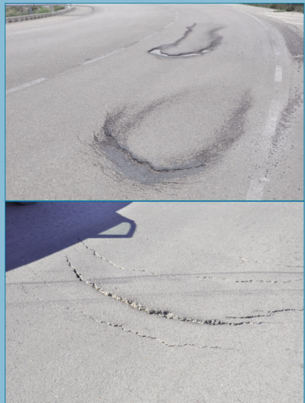
Figura 67. Grietas parabólicas.
