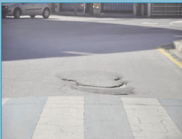
Figura 68. Grieta parabólica con arrollamiento de la mezcla bituminosa.
