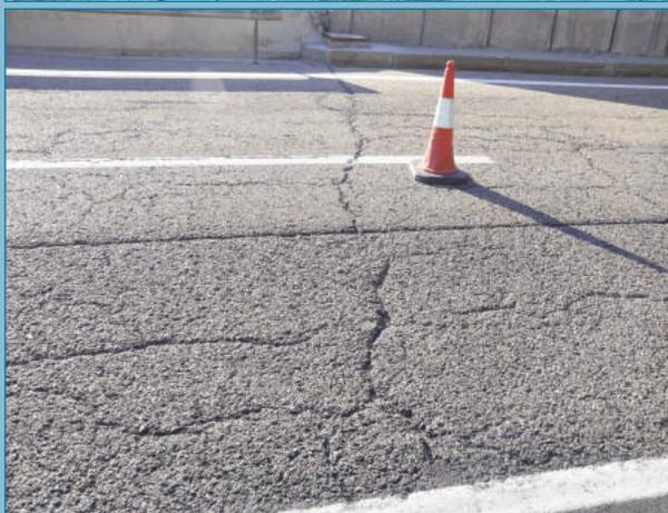
Figura 58. Grietas descendentes en estado avanzado. Procede colocar una nueva capa de mezcla bituminosa.
