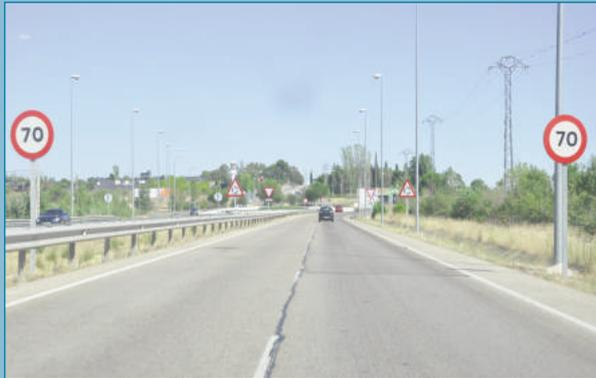
Figura 65. Sellado de grietas constructivas.
