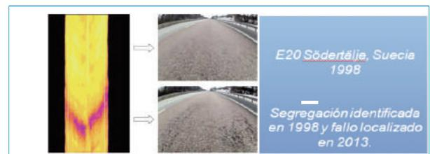
Figura 16. Efecto de las zonas frías en el extendido sobre el comportamiento del pavimento. Fuente [7]
