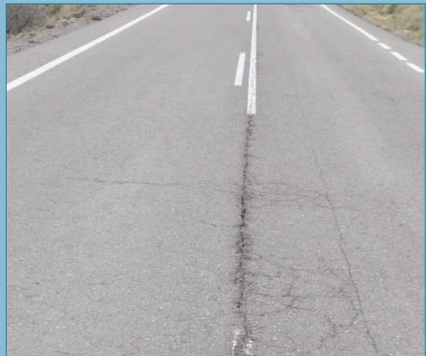
Figura 64. Deterioros peligrosos asociados a las grietas constructivas.
