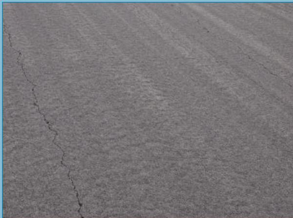
Figura 54. Fisuración descendente en pista de aeropuerto.
