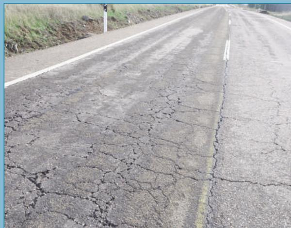
Figura 56. Agrietamiento descendente generalizado con inicio de pérdida de material.
