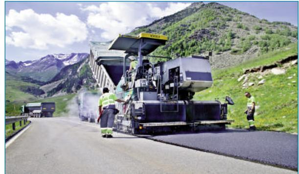
Figura 1. Extendido de una capa ultrafina
