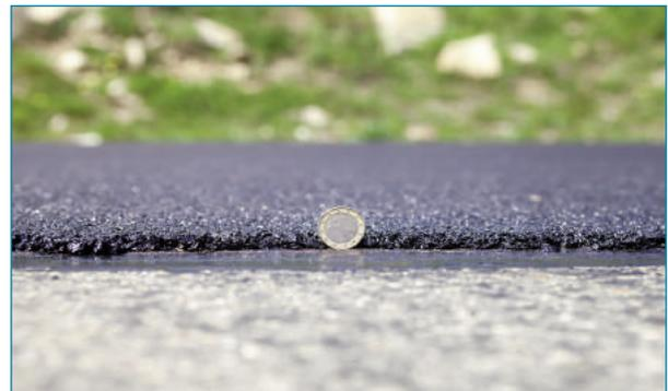
Figura 2. Detalle del espesor de una capa ultrafina
