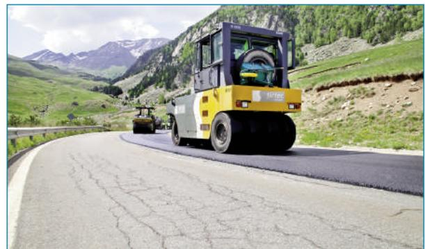
Figura 3. Extendido de una capa ultrafina sobre una superficie fisurada
