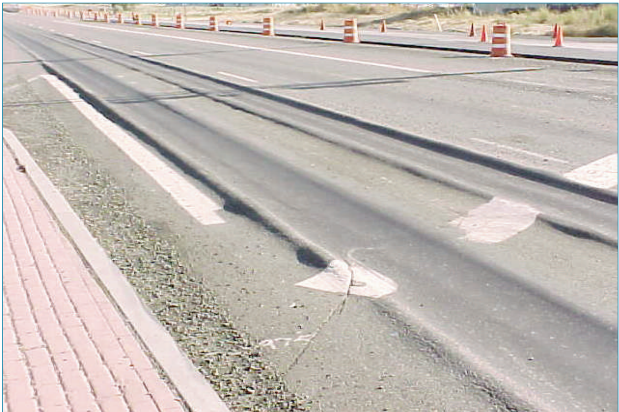
Ilustración 1: Deformación plástica (roderas)
