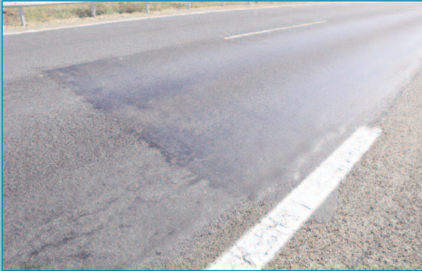
Figura 103. Exudaciones en tratamientos de lechada bituminosa o micro en frío (ligante blando).
