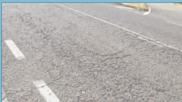
Figura 95. Descarnadura en fase muy avanzada que requiere fresado y reposición total de la capa.
