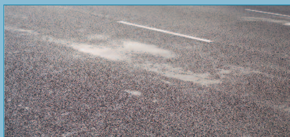
Figura 102. Exceso dotación riego de adherencia.
