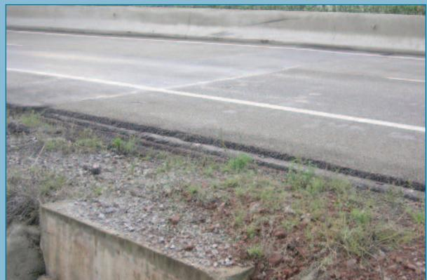
Figura 120. Escalón producido por la presencia de una estructura.
