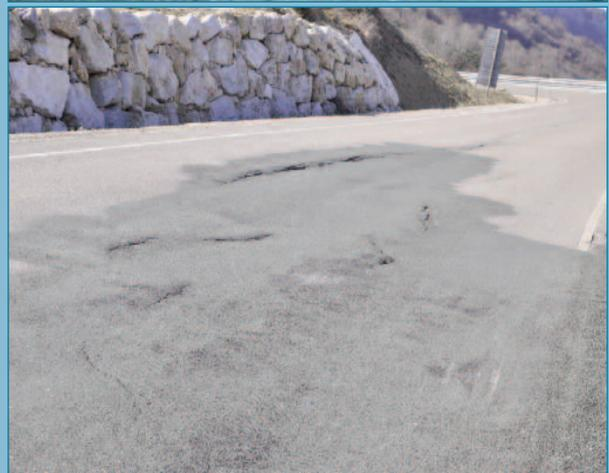
Figura 119. Escalón debido a asentamiento localizado de las capas inferiores.
