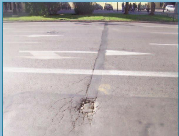
Figura 122. Escalón producido por asentamiento de zanja mal reparada.
