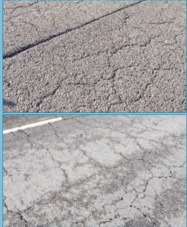
Figura 124. Agrietamiento de la capa de rodadura afectada por el vertido de sales como tratamiento anti hielo y las bajas temperaturas.
