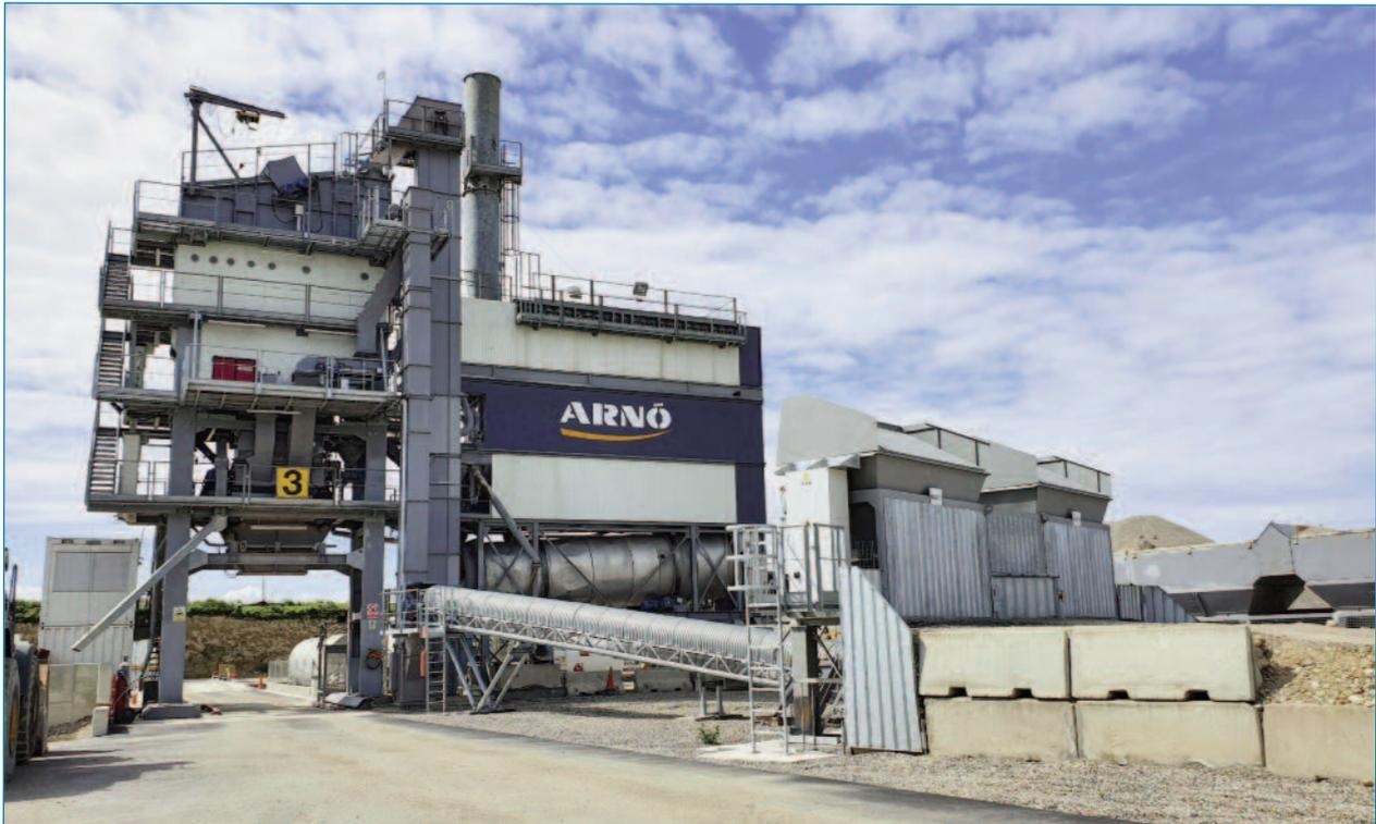
Figura 10. Grupo de dos tolvas para introducción de RAP y árido directamente a la mezcladora de la central para la producción de mezclas recicladas y a baja temperatura.
