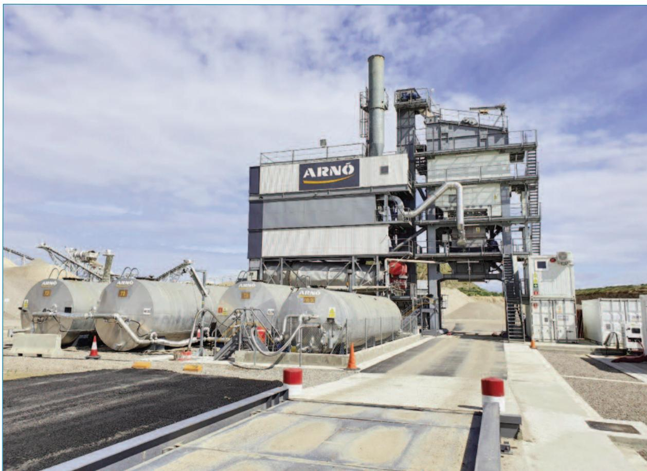
Figura 8. Vista general de una central de fabricación de mezclas bituminosas en caliente adaptada para la producción de mezclas recicladas y a baja temperatura.
