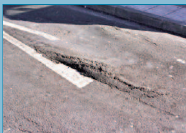
Rodera con deformación
