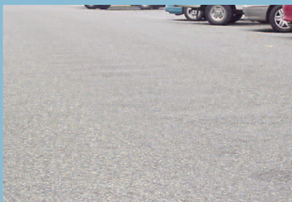
Ondulaciones de onda corta
