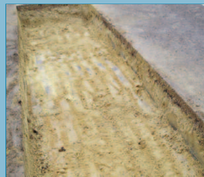
Operaciones de saneo de la zona afectada por un blandón.
