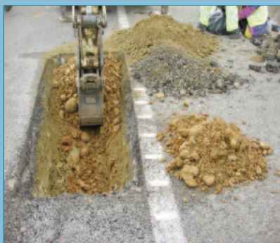
Operaciones de saneo de la zona afectada por un blandón.
