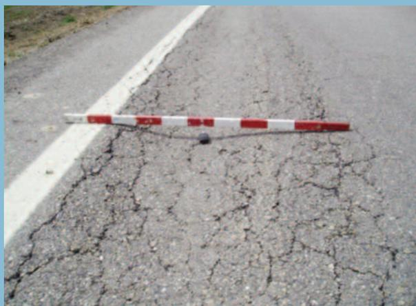
Blandón donde se aprecia el hundimiento del firme
