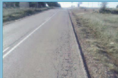
Roderas por asentamiento de las capas granulares inferiores del firme
