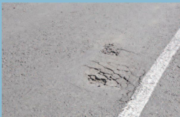
Hundimiento localizado por defecto del drenaje
