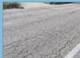
Diversos grados de agrietamiento estructural de un firme (de menor a la izquierda, a mayor a la derecha)
