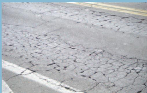
Fisuración estructural en zona de rodada
