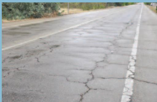
Fisuración descendente longitudinal y posteriormente con fisuras transversales en todo el pavimento
