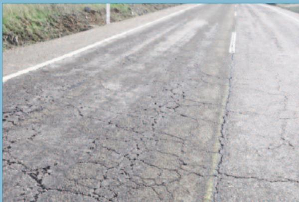
Agrietamiento descendente generalizado con inicio de pérdida de material. Procede colocar una nueva capa de mezcla bituminosa
