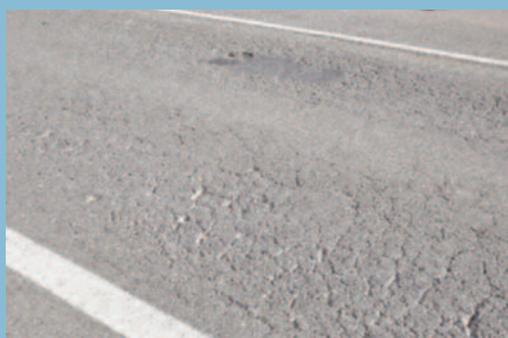
Grietas estructurales por fatiga de las capas granulares
