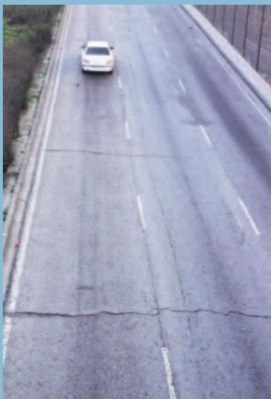
Fisuración estructural en zona de rodada
