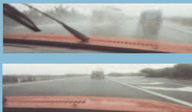
Comportamiento con lluvia de un pavimento normal y otro drenante
