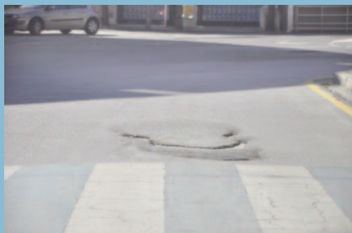
Grieta parabólica con arrollamiento de la mezcla bituminosa
