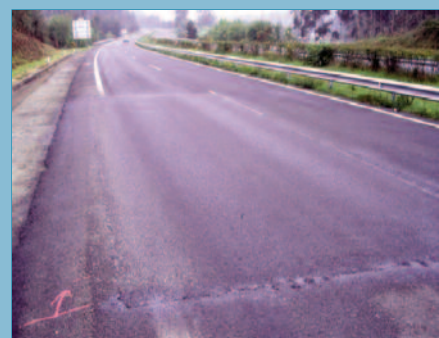
Reparación hasta el borde de un pavimento drenanteperalte
