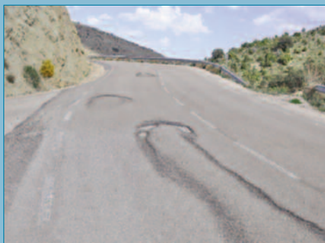
Grietas parabólicas con desprendimiento de material suelto de la mezcla bituminosa
