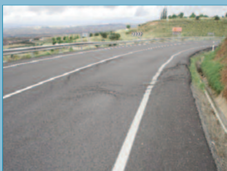
Grietas parabólicas afectando a carril completo e incluso al arcén
