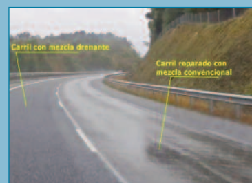
Efecto de carriles con diferente textura
