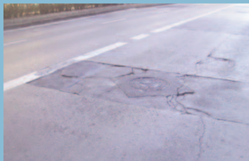
Deterioros alrededor de grietas constructivas
