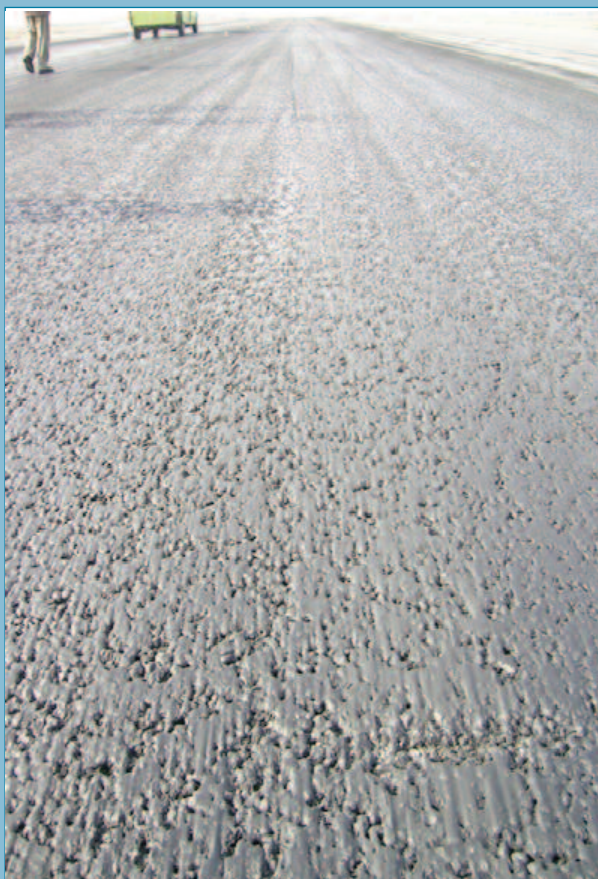
Depósito de caucho en toma de tierra de los aviones en pista aeropuerto
