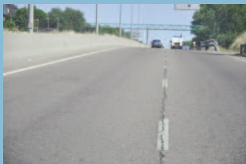
Grieta constructiva entre capas de mezcla bituminosa contiguas y extendidas por separado
