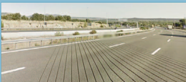
Ranurado transversal en zonas de transición de peralte
