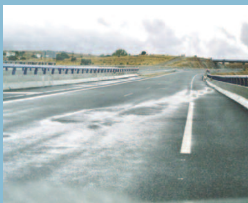
Formación de charcos de agua localizados en un pavimento drenante
