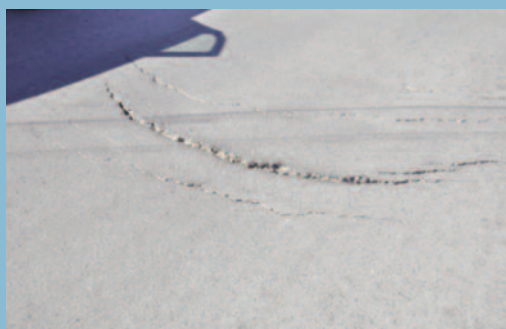
Grietas parabólicas
