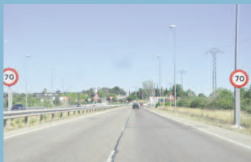
Sellado de grietas constructivas
