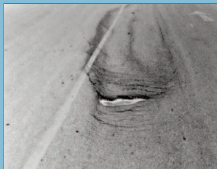
Grietas parabólicas con desprendimiento de material suelto de la mezcla bituminosa
