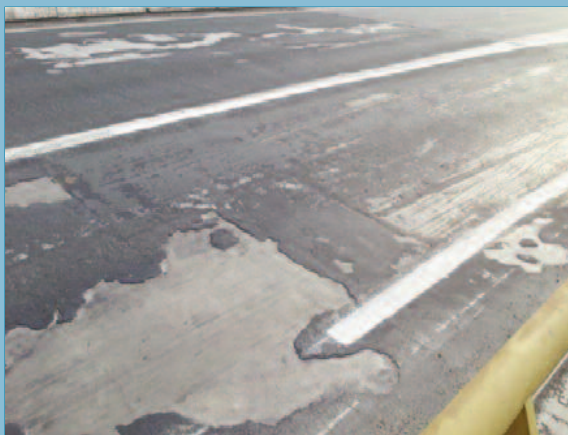
Peladuras en capas bituminosas muy delgadas sobre pavimento de hormigón
