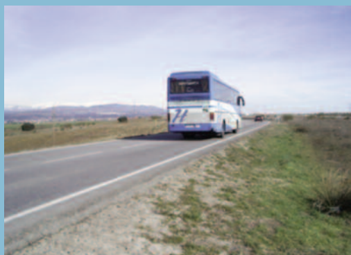
Arcén con anchura muy escasa
