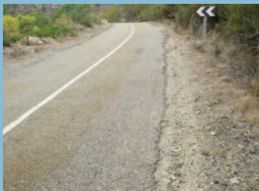
Arcén inexistente, y calzada reducida por mordientes laterales deteriorados
