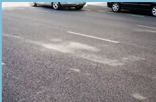
Exceso dotación del riego de adherencia
