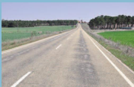
Peladura generalizada en una capa de lechada bituminosa
