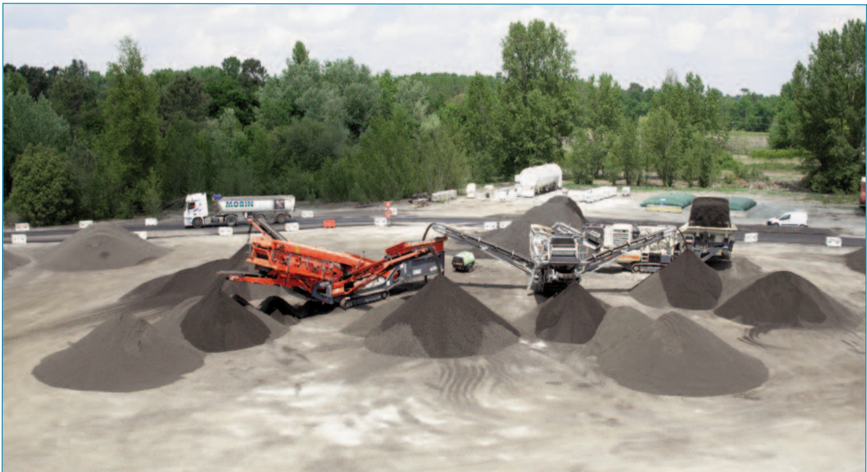
Foto 2. Cribado y acopio de las fracciones de fresado
