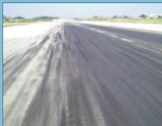
Depósitos de caucho de los neumáticos en la zona de toma de tierra de pistas de vuelo de aeropuertos
