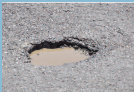
Baches producidos por causas relacionadas con la puesta en obra
