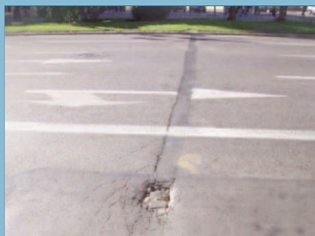
Escalón producido por asentamiento de zanja mal reparada
