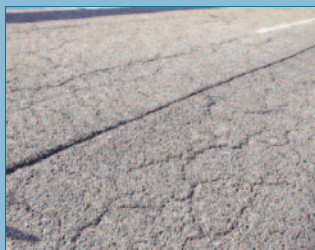
Agrietamiento de la capa de rodadura afectada por el vertido de sales como tratamiento anti hielo y las bajas temperaturas
