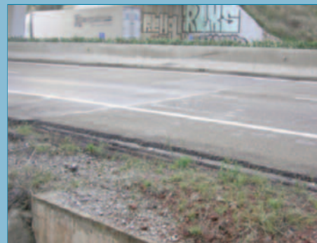
Escalón producido por la presencia de una estructura.
