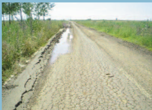
Surgencias de finos y agua en distintos tipos de firmes
