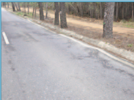
Escalones producidos por afeción al firme de las raíces de los árboles próximos a la carretera
