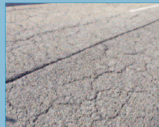
Agrietamiento de la capa de rodadura afectada por el vertido de sales como tratamiento anti hielo y las bajas temperaturas
