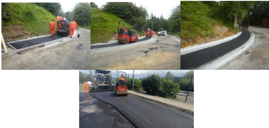
Foto 8: Extendido y compactación de la mezcla sostenible en la nueva acera y en el vial de acceso al colegio.
