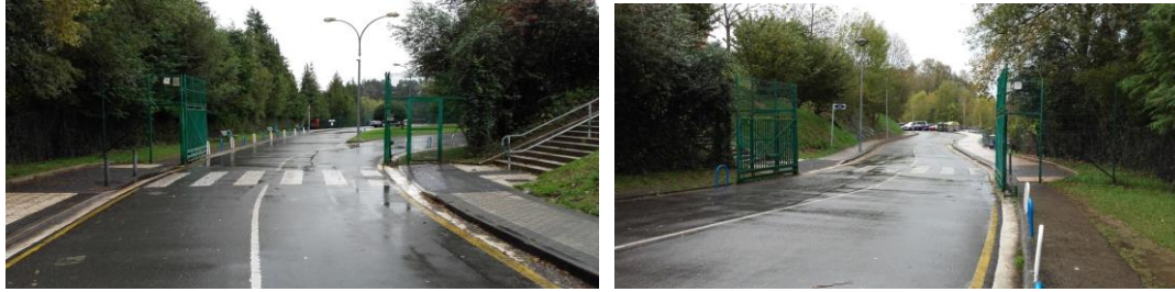
Foto 1: Foto de acceso hacia el interior del colegio (izq.) y hacia el exterior del colegio (dcha.) ambas antes de la actuación.
