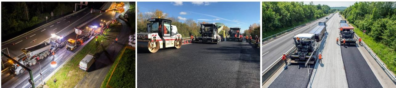
*Figura 8: Diversas obras experimentales con Biophalt® en autopistas francesas (izda: autopista del Túnel de Montblanc; centro: A40; dcha: A34)*
