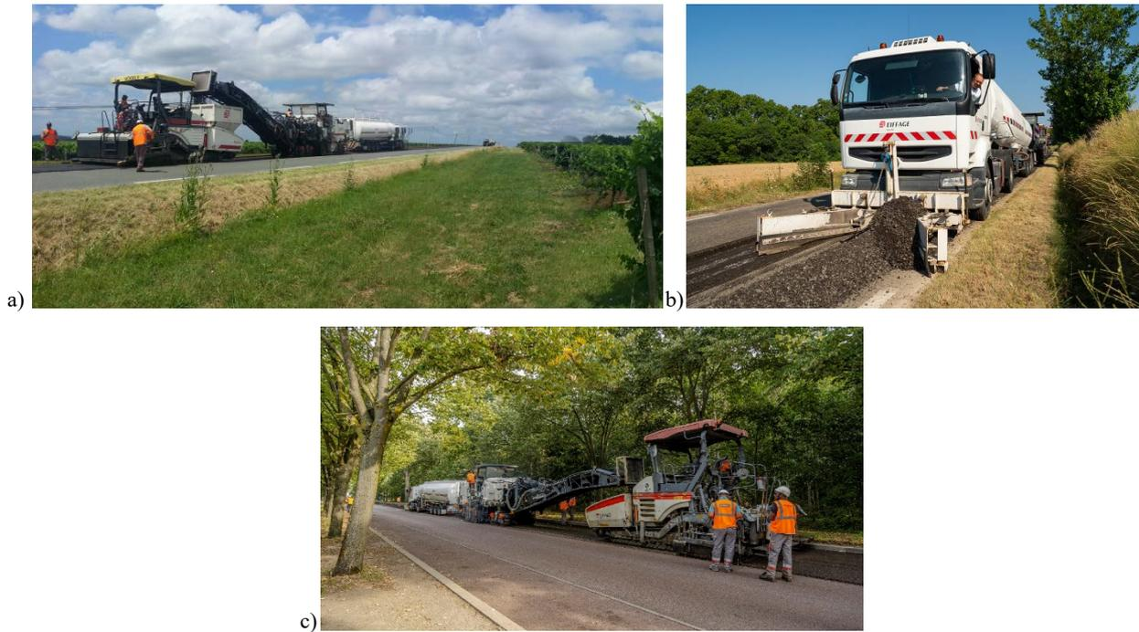
Figura 5: Obras con especial seguimiento para validación del reciclado con la emulsión vegetal. a) RD670 (2018); b) RD26 (2018); c) Bosque de Vincennes (París) (2019)
