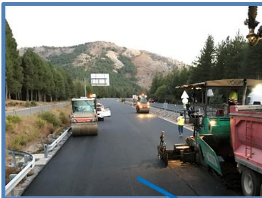
Autovía A-92 (Puerto de la Mora), 650 t MASAI (I) Septiembre 2017
