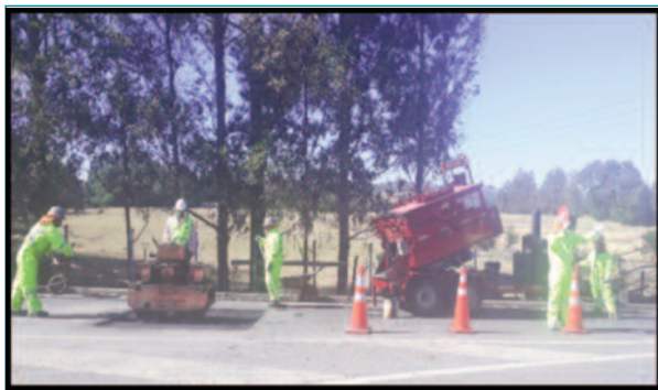
Figura 6. Compactación de mezcla asfáltica reciclada.
