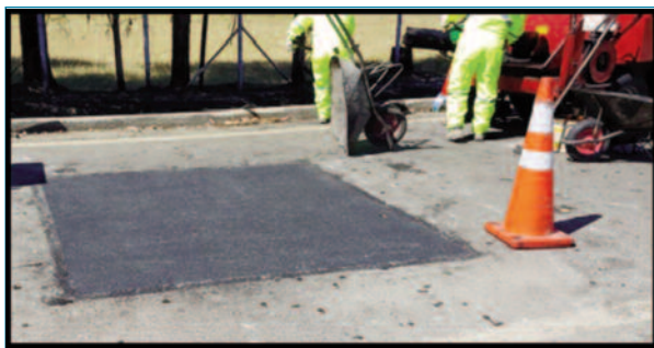
Figura 7. Reparación de área deteriorada.
