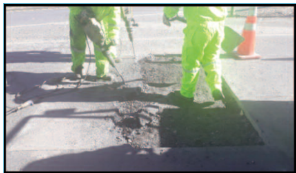
Figura 3. Remoción área deteriorada.
