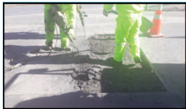
Figura 3. Remoción área deteriorada.
