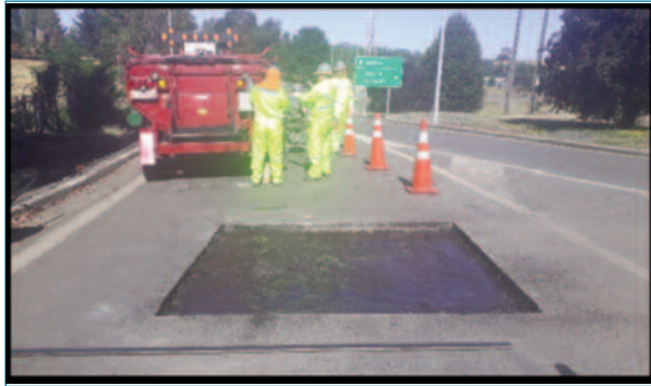
Figura 4. Área a reparar con riego de liga.
