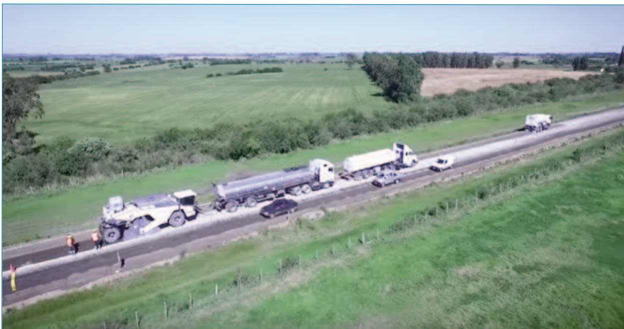
Figura 10 Tren de reciclado in situ
