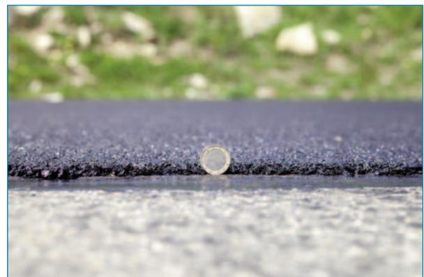
Figura 1. Extendido de una capa ultradelgada y detalle del espesor (Fotos: Sorigué)
