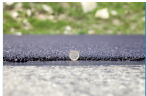
Figura 1. Extendido de una capa ultradelgada y detalle del espesor (Fotos: Sorigué)
