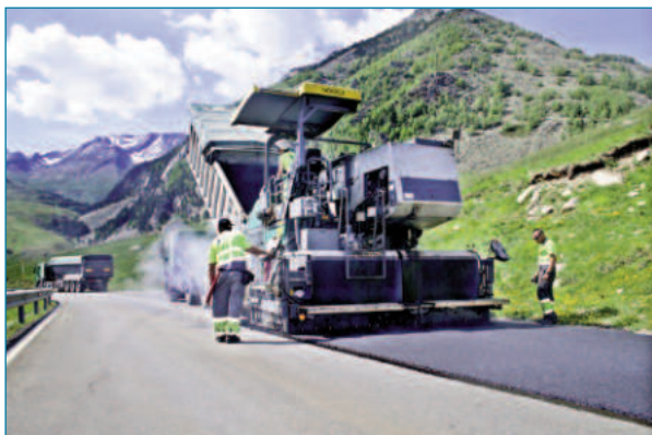
Figura 1. Extendido de una capa ultradelgada y detalle del espesor (Fotos: Sorigué)
