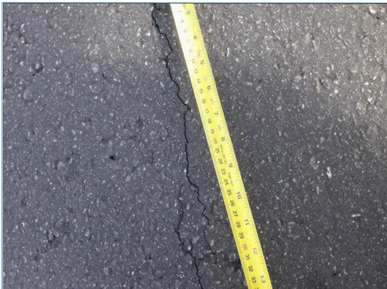
Figura 11. Fisuración encontrada en mezcla asfáltica
