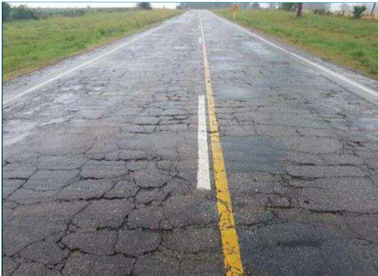
Figura 2. Estado previo del pavimento a rehabilitar
