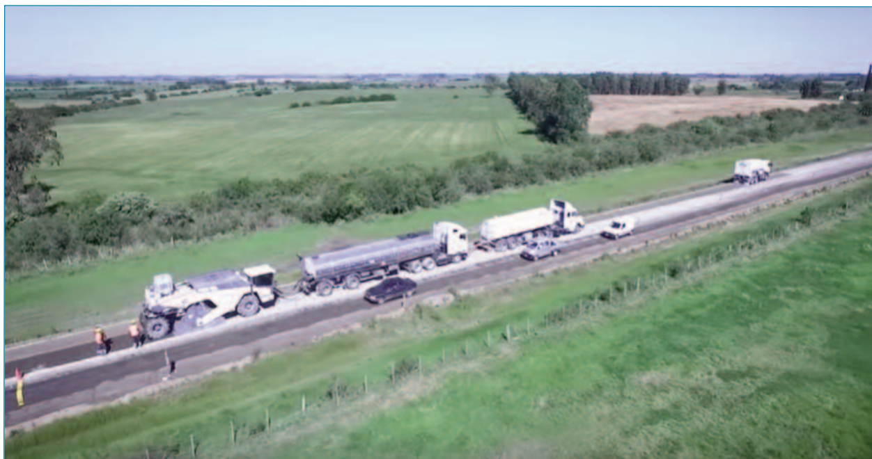
Figura 10 Tren de reciclado in situ
