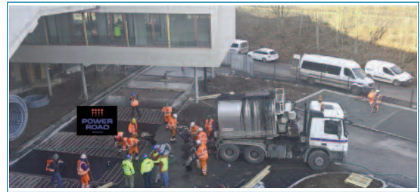
Figura 14. Instalación Power Road® en Praga
