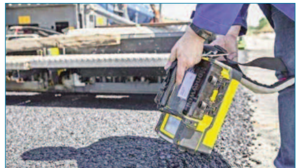
Imagen 3: La colocación de la mezcla asfáltica basada en el bitumen modificado reactivamente estuvo acompañada de la medición de las emisiones nocivas; no se encontraron emisiones adicionales específicas del producto.
