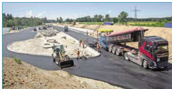
Image 2: Vistas del sitio de construcción en la A96 durante la instalación de la capa de ligante modificada reactivamente (derecha) y la sección de control (izquierda)
