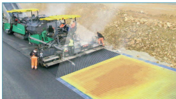
Disposición del escáner y el área muestreada
