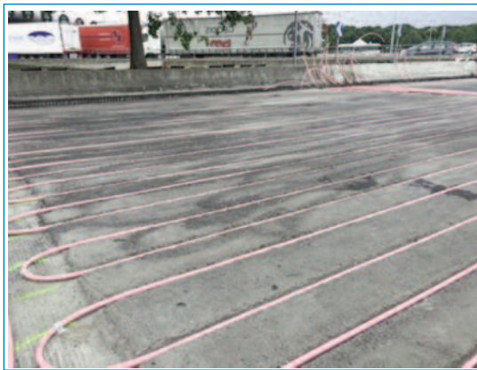
Figuras 10 y 11. Instalación de los tubos mediante hincia
